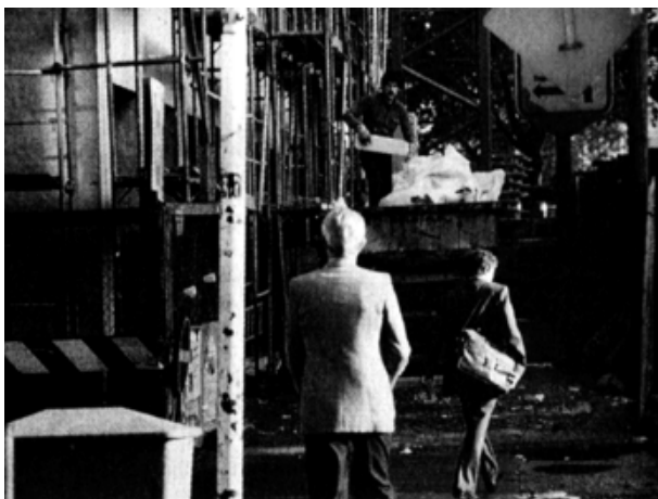
Alis auf der Baustelle, Köln Wohnpark Hohenstaufenring.
